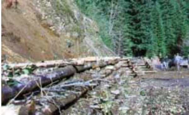
Anexo 15: Muro de cuna vivo o Live Cribwall (Fuente: Keller para NCHRP & USDA)
