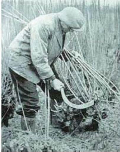
Figura 7: Europa a principios del siglo XX. Corte y recogida de tallos vivos para bioingeniería de suelos. (Fuente: Kevin Finney)
