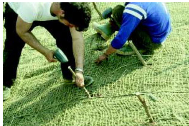
Anexo 18: Estacas vivas o Live Stakes (Fuente: Sotir & Associates for USDA, 1992)
