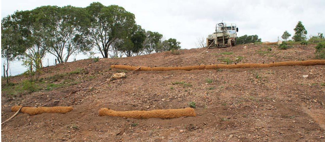
Anexo 13: Rollo de fibra de coco (Coconut Fiber Roll) (Fuente: Aussie Environmental, 2019)
