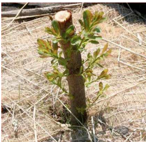
Anexo 18: Estacas vivas o Live Stakes (Fuente: Sotir & Associates for USDA, 1992)
