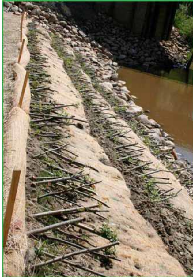
Anexo 11: Capas de cepillos con estacas vivas (Brush layering) (Fuente: Sotir para NCHRP, 2012)
