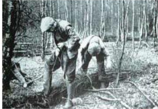
Figura 7: Europa a principios del siglo XX. Corte y recogida de tallos vivos para bioingeniería de suelos. (Fuente: Kevin Finney)
