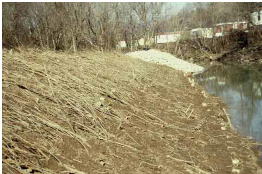
Anexo 12: Colchón de cepillos (Brush Mattress) (Fuente: Sotir & Associates para USDA, 2000)
