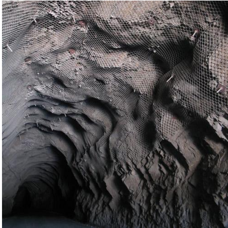
Figura N°15. Foto de una excavación subterránea revestida con malla. Fuente RGM - Alambre y Mallas.
