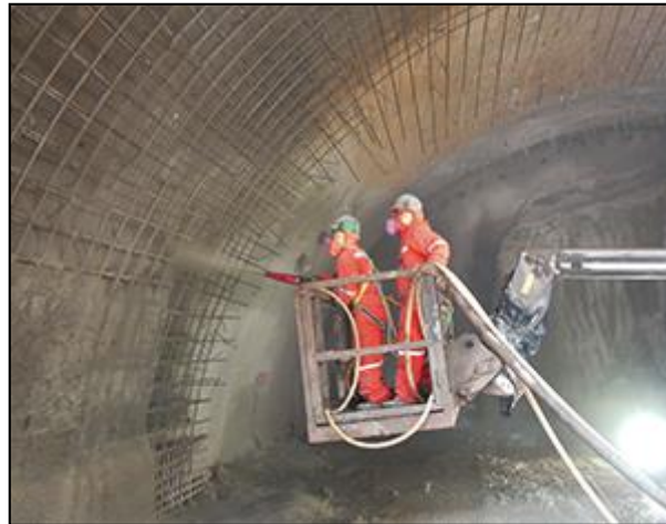
Figura N°16. Fotografía de equipo de mineros proyectando shotcrete desde un equipo en altura. Fuente www.construccionminera.cl
