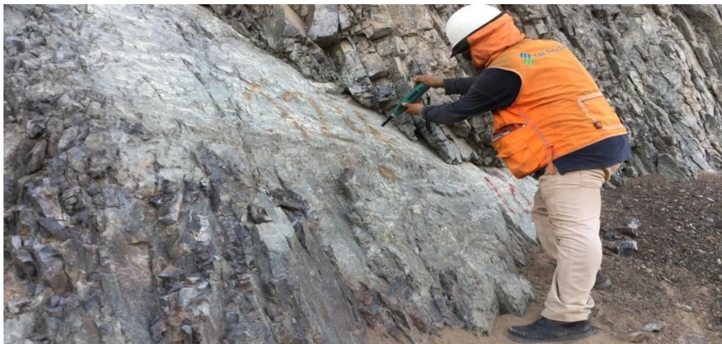
Figura N° 6-11 Ejecución del Ensayo con el Martillo Schmidt (EG-01)
